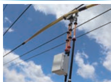
電動型防護管挿入機
