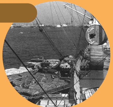
輸出OFケーブル船積み風景
