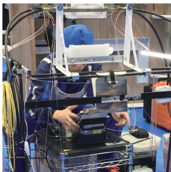
当社製融着機での 接続作業
