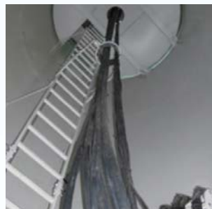
風力発電タワー内耐捻回ケーブル
