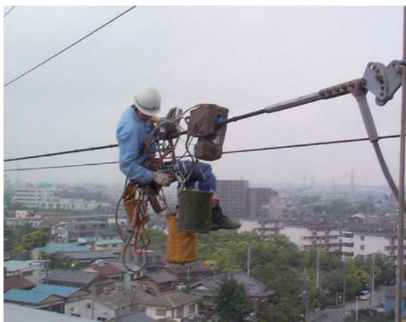
現場作業状況
