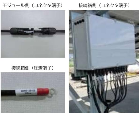
図3 太陽電池モジュールから接続箱間 ケーブル使用例
