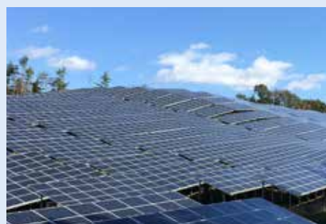
施工事例：日本最大級メガソーラ発電所 2019年12月稼働開始
