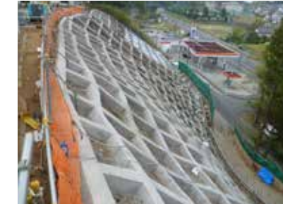
佐倉事業所の法面工事
