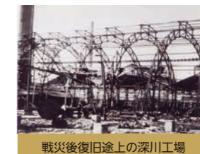
戦災後復旧途上の深川工場
