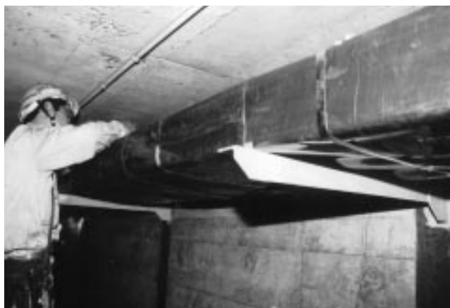
図8 エフシートの布設状況
