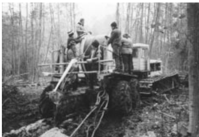
図8 ロシアにおけるケーブル布設風景
