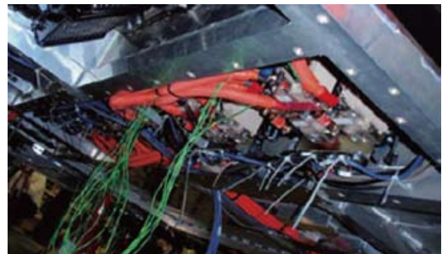
図 5 高電圧ケーブル Fig. 5. High voltage cable.
