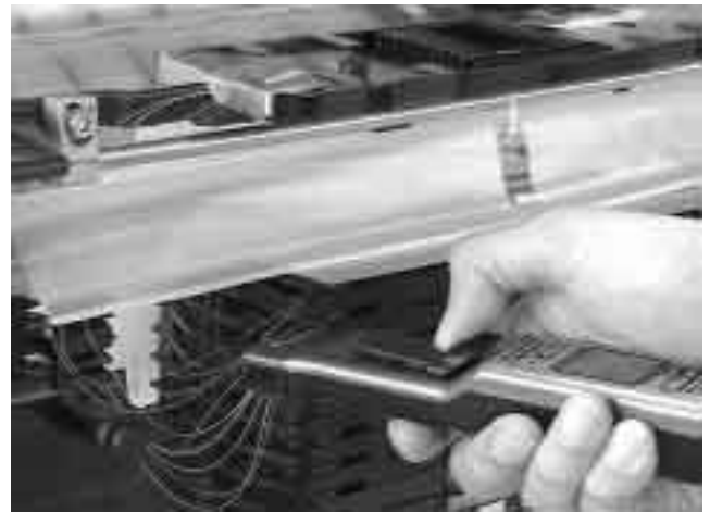
図7 クロージャ内での心線対照作業 Fig. 7. Identification work in splice closure.
