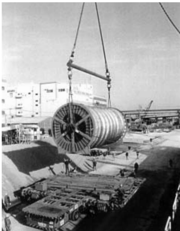
図3 ケーブル引き入れ状況(1) Photograph of cable laying
