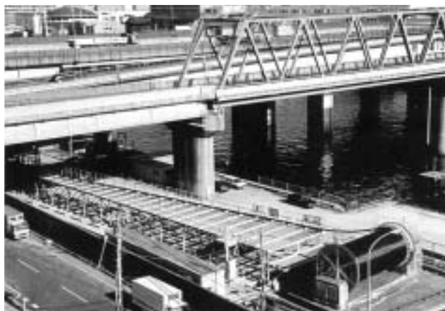
図4 ケーブル引き入れ状況(2) Photograph of cable laying
