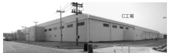
図5 PCTTアユタヤ工場C棟 PCTT Ayutthaya C Factory
