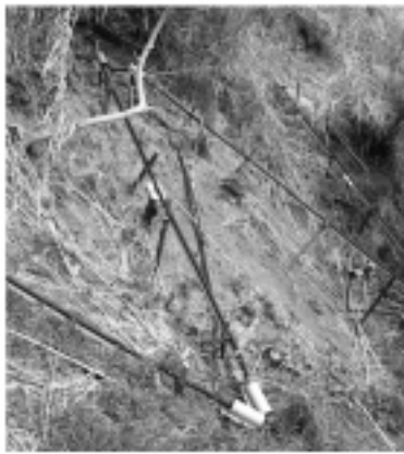
図11 光ファイバセンサ斜面設置状況 Setting situation for optical fiber sensors
