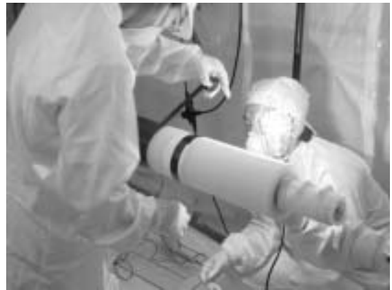
図10 ジョイント接続作業 Joint assembling work
