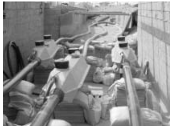
図11 ジョイント接続状況 Prefabricated joint in coffin box
