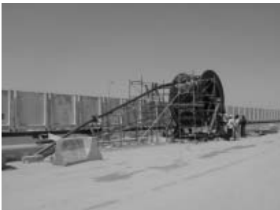
図9 ケーブル布設状況 Cable laying work
