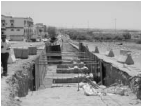
図8 トレンチ掘削 Cable trench
