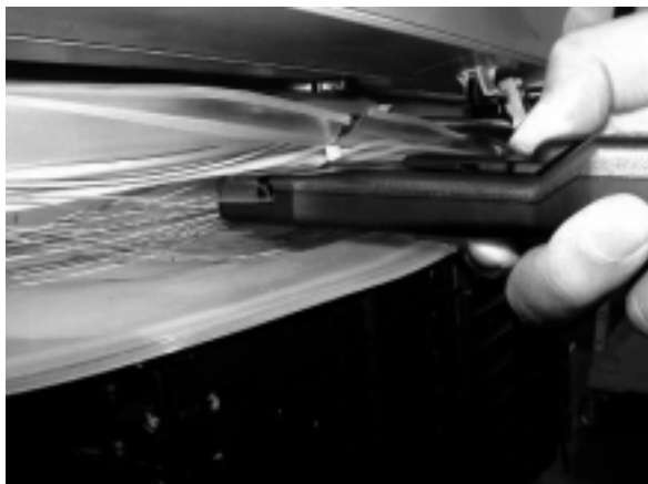
図8 クロージャ内での新型器による対照作業 Fig. 8. Identification with new identifier in closure.
