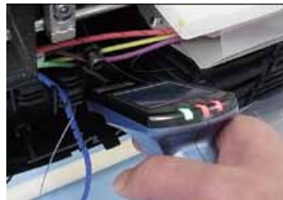
図6 クロージャ内での心線対照作業 Fig. 6. Identification work in splice closure.
